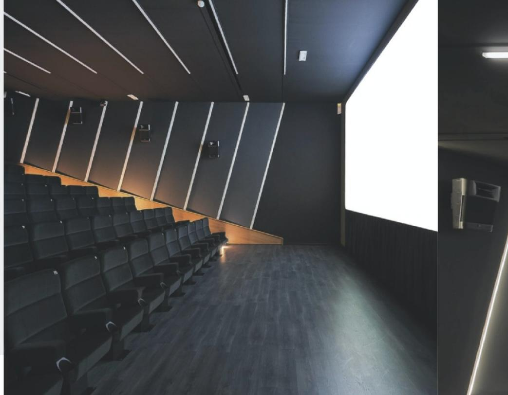
con schermo diffusore in opale piatto trasparente, utilizzate in dimmerazione 20%-40% con le prime. Per quanto riguarda le LED strip a luce bianca (c) queste sono state destinate per l'illuminazione interna di tutte le sale, con una esecuzione realizzata appositamente con una più bassa potenza e un fattore di interdistanza (LED/metro lineare) più alto, per mascherare l'effetto puntinato percepito dai fruitori delle sale, in quanto posizionate a vista e ad altezza occhi spettatore.
